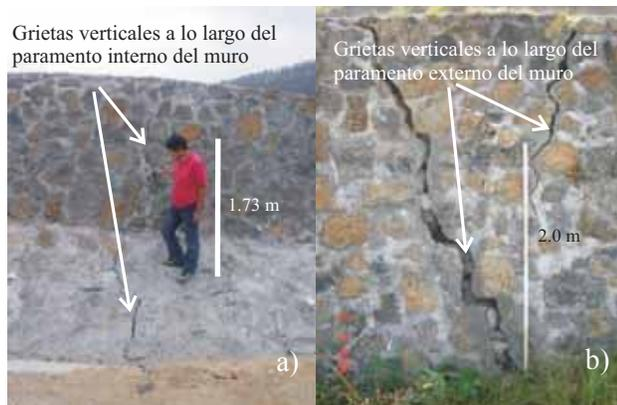
Figura 8a, 8b. Grietas verticales, generadas por el movimiento del muro de contención. La diferencia de tiempo en la captura de las fotos muestra el ensanchamiento progresivo de las grietas verticales. (Enero 2003, Septiembre 2004).
